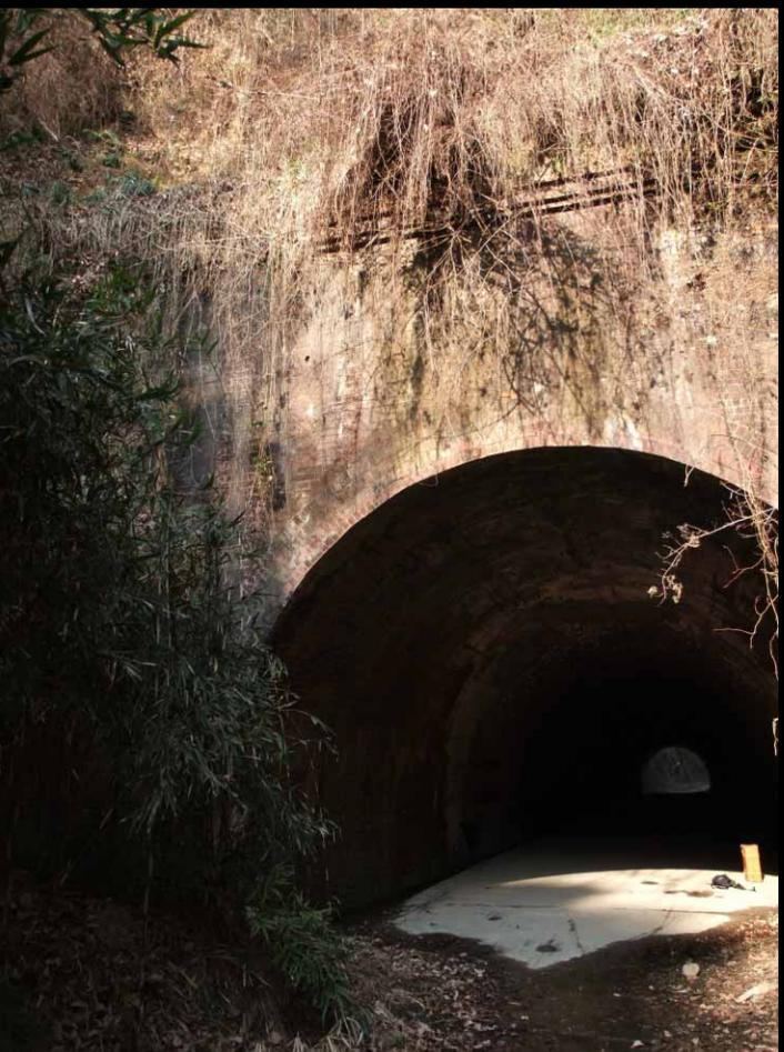
▲青梅街道畑隧道南口。三段に繰り出した笠石を含め総煉瓦造でピラスターは非採用。北口は崩落を後補した別意匠。
