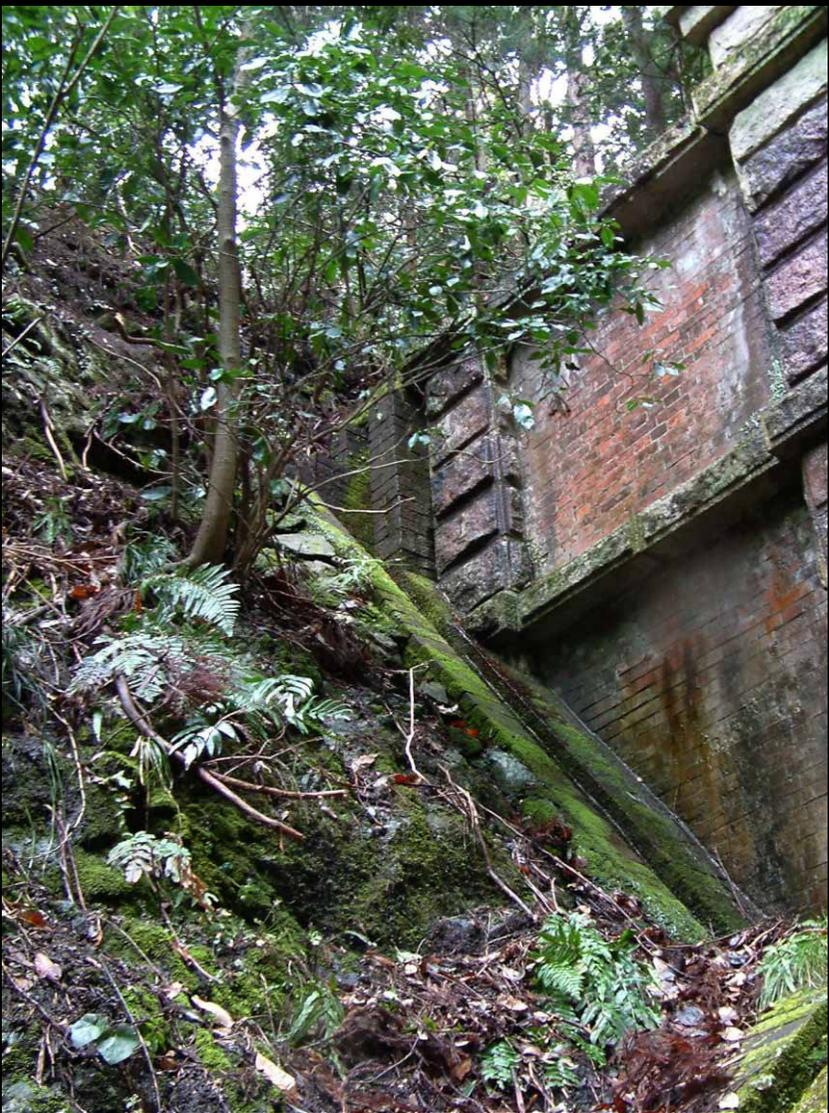
▲横山隧道菅生口の排水渠。ポータル意匠と一体化する形で煉瓦造の溝が切られている。排水渠の下段はポータル面と垂直方向を向いて、それ自体がポータル面を支持する控え壁の役割も果たしているのが地味に秀逸である。佐和山隧道にも全く同じ作りの溝あり。
