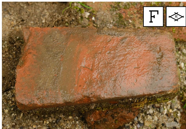
大型楕円井筒用撥形異形煉瓦「G」 + 「井桁+七」、撥形異形煉瓦「F」 + 「井桁+廿一」（刈谷市司町転石）
