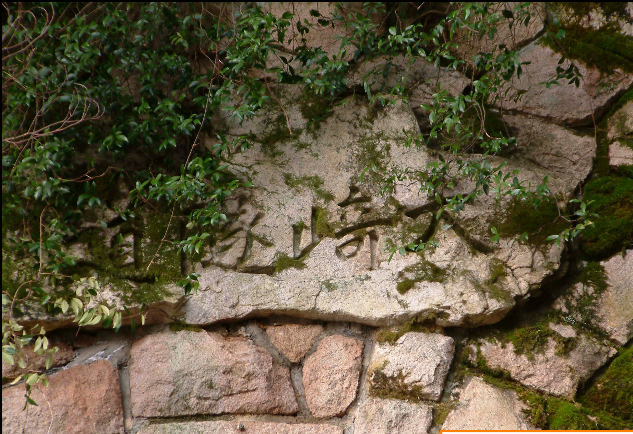
大崎第一隧道 扁額
