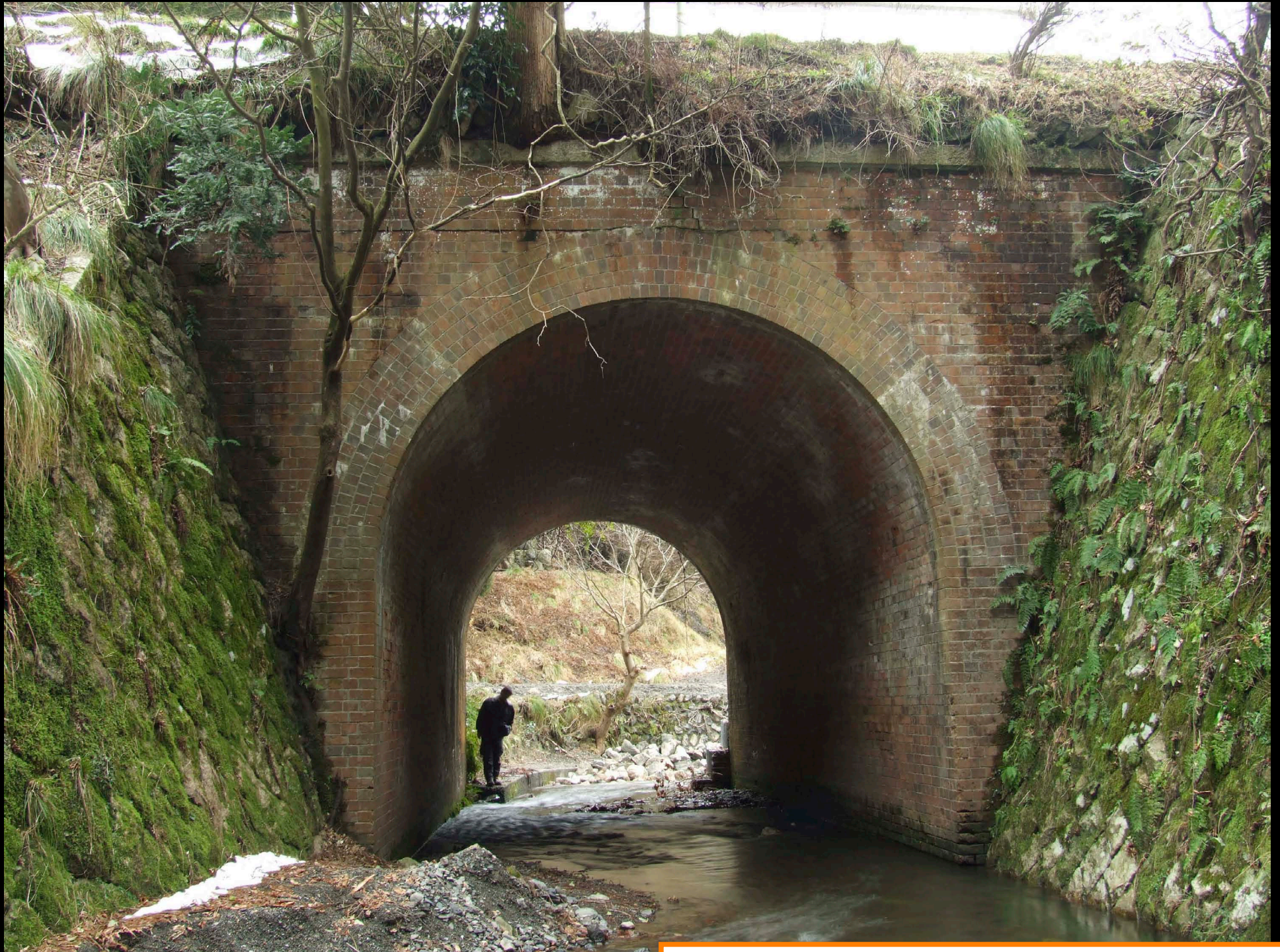
若狭街道 保坂カルバート（明治 23 年竣工？）
