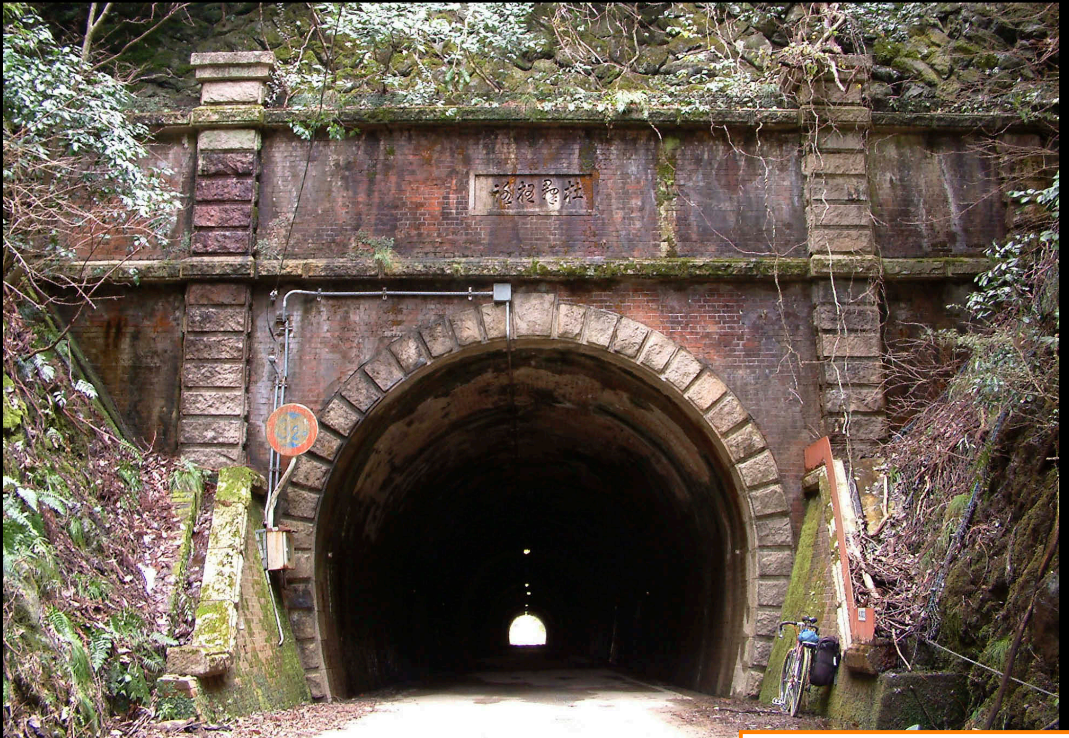
横山隧道 東口
