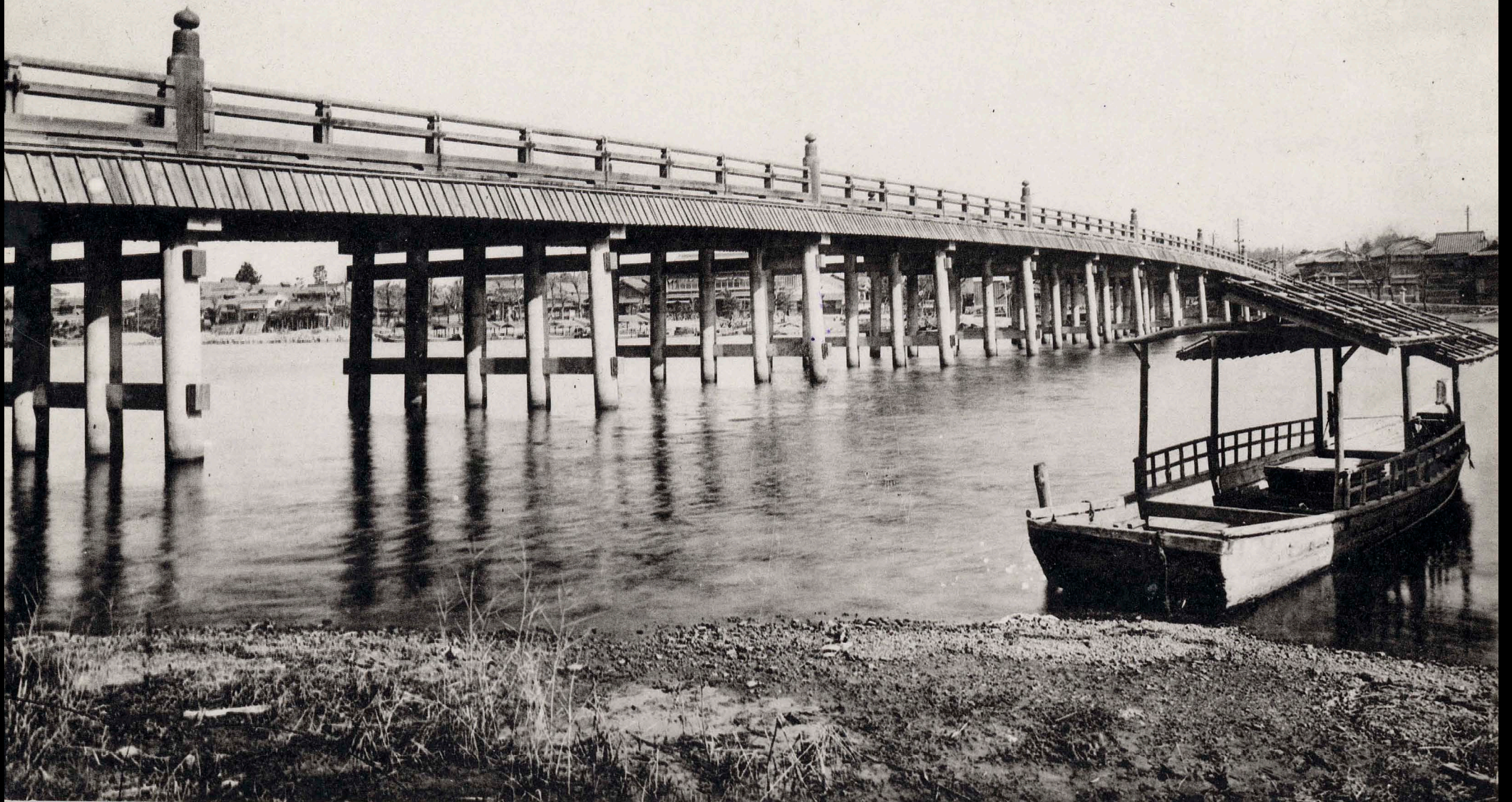
瀬田の唐橋 (大正 13 年架換)
