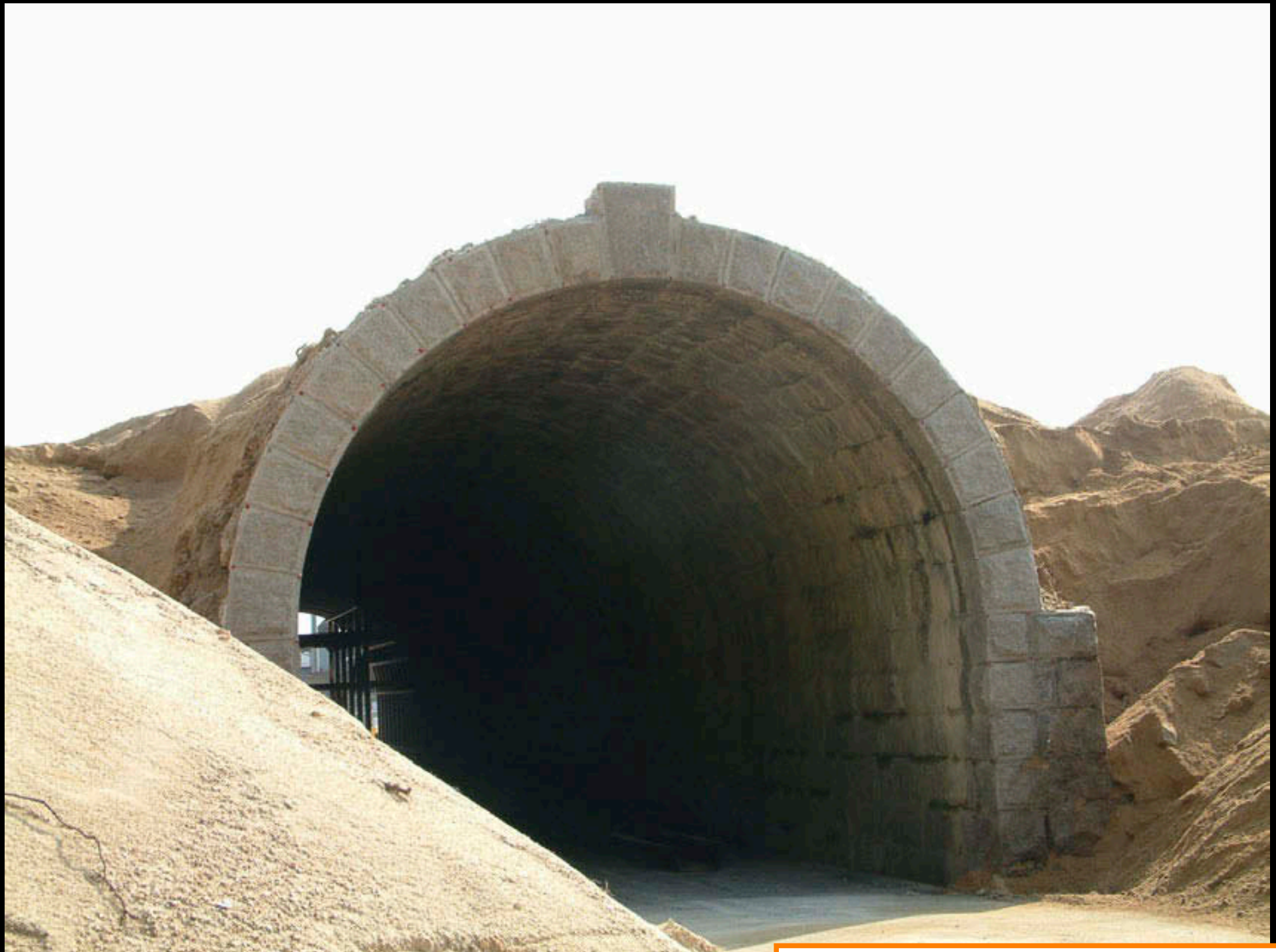
解体中の家棟隧道（平成18年9月）
