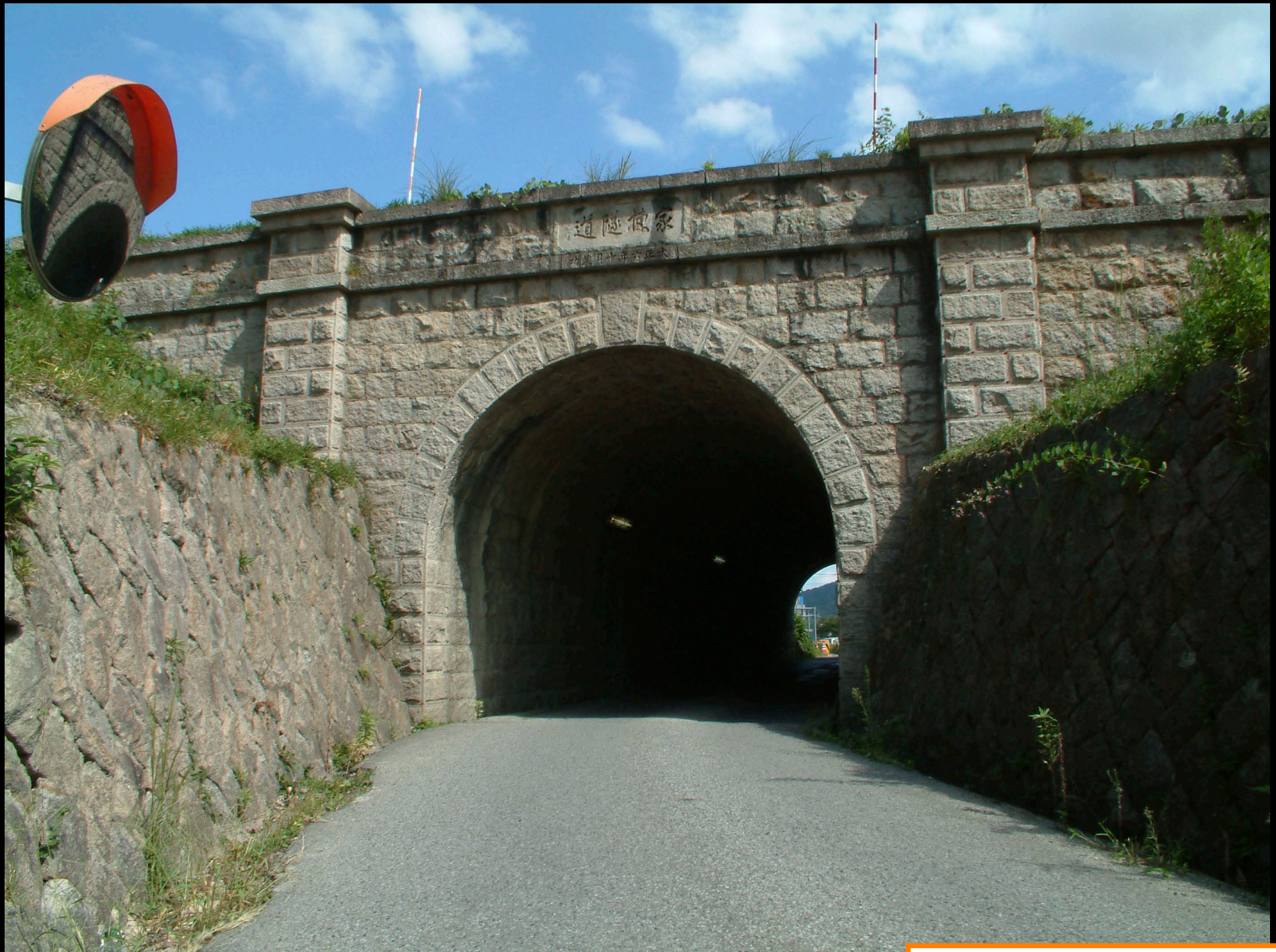
家棟隧道 (大正6年10月竣工)
