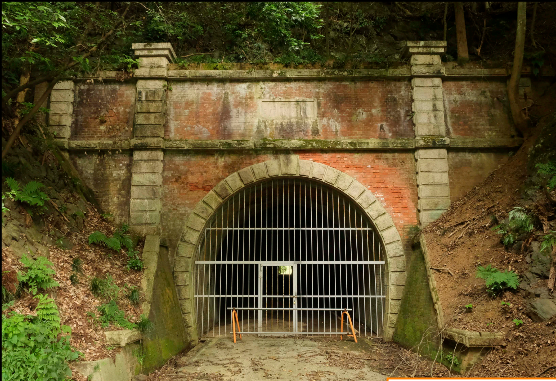
横山隧道 西口
