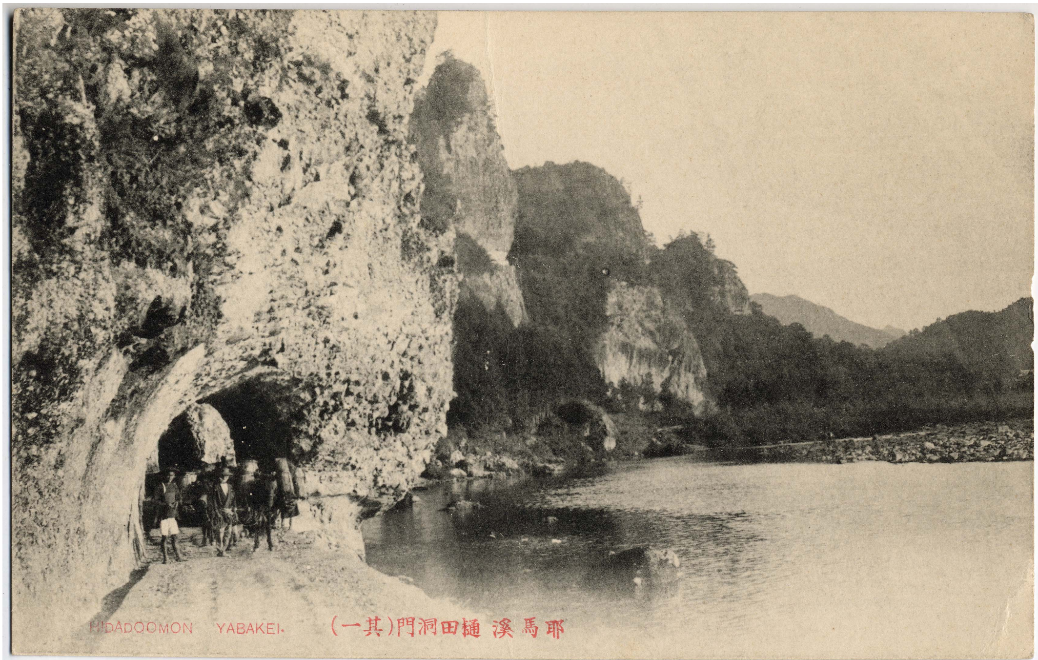
第三洞前から南を見る。改修前
